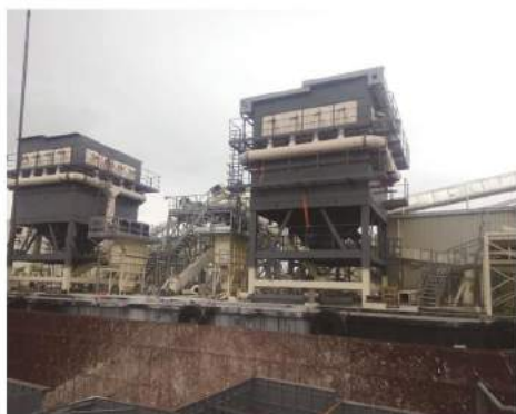
香港客户40m³随船移动式环保除尘漏斗 (物料：水泥熟料)
